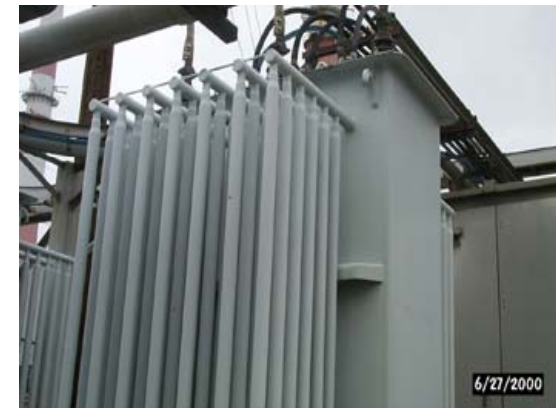
Monitoraggio livello di olio per il raffreddamento di un trasformatore
